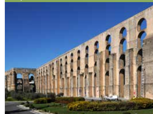
Aquaduto da Amoreira
