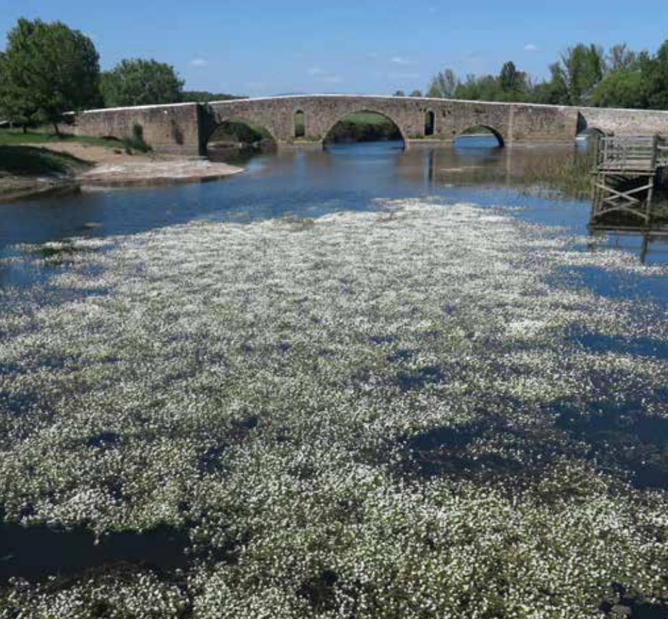
Ponte Romana sobre a Ribeira Grande
