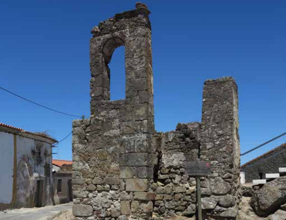
Ruínas de igreja em Vila Flor
