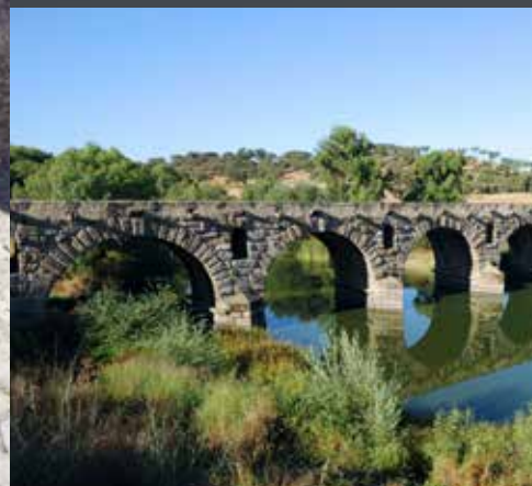
Ponte romana de Vila Formosa
