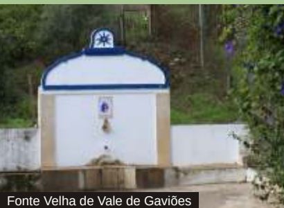
Fonte Velha de Vale de Gaviões
