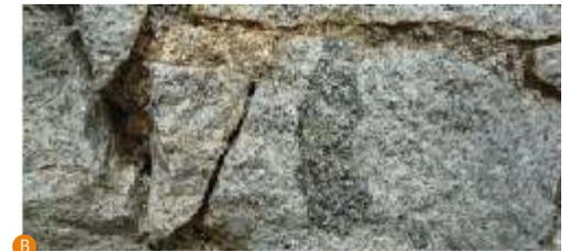
Fig. 5 - Antigo lagar (rua Inácio Cabrita) construído em alvenaria de sienito. A – Aspeto geral do edifício. B – Pormenor das paredes construídas com blocos de sienito nefelínico, podendo-se identificar um xenólito (fragmento de rochas pré-existentis incluído noutra rocha) de uma rocha mais escura.
