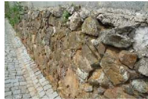
Fig. 3 - Muro (rua Inácio Cabrita) construído em alvenaria de pedra natural (vários tipos de rochas locais – grauaque, corneana, sienito nefelínico).
